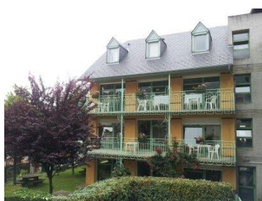
Bâtiment extension : construit en 1999,
